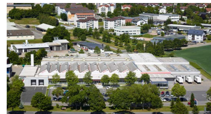
Das Sheddach ist nun für eine bessere Heizwirkung überbaut.
